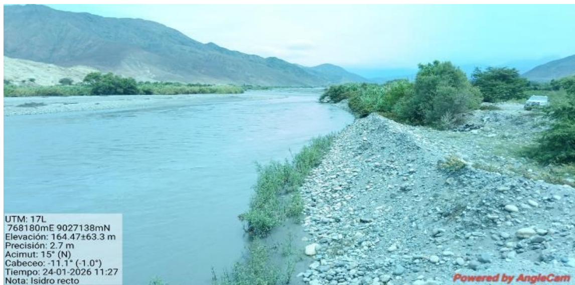
FIGURA N°01: TRAMO CRÍTICO EN EL RÍO SANTA, NO HAY PROTECCION EN LA MARGEN IZQUIERDA, SE PLANTEA LA PROTECCION CON DIQUE CON ENROCADO EN UNA LONGITUD DE 150 ml, COLOCACION EN UN PUNTO (01) UN ESPIGON; EN EL SECTOR SAN ISIDRO RECTO I - VINZOS, DISTRITO DE CHIMBOTE, PROVINCIA DE SANTA - ANCASH.
